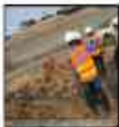
Kendali 1011: Mengurangi IFE di lereng
